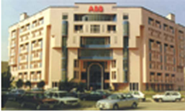
The building After construction المبنى بعد التنفيذ
